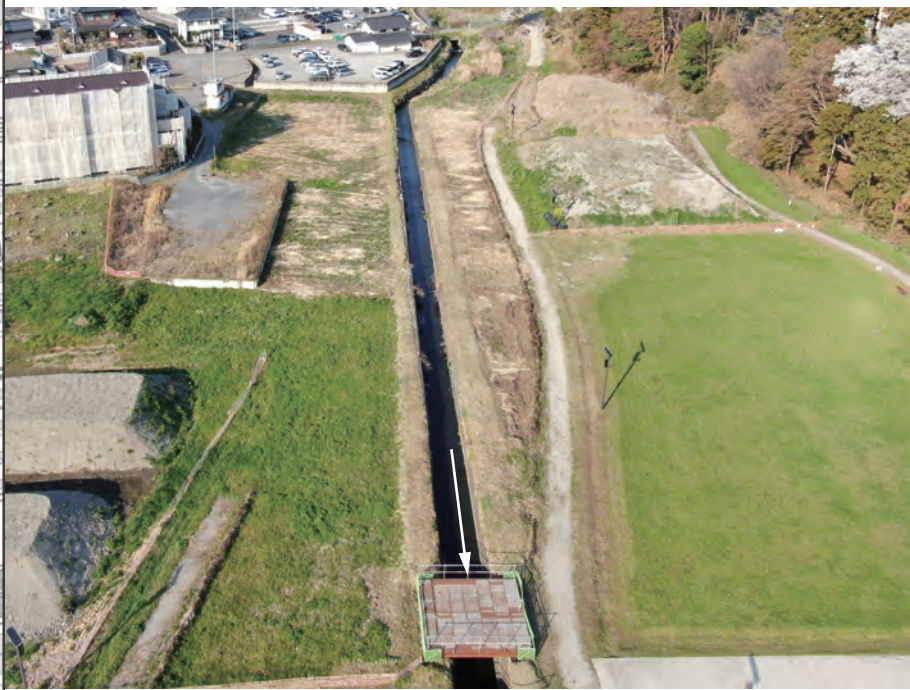
▲工事前の一級河川中丸川
